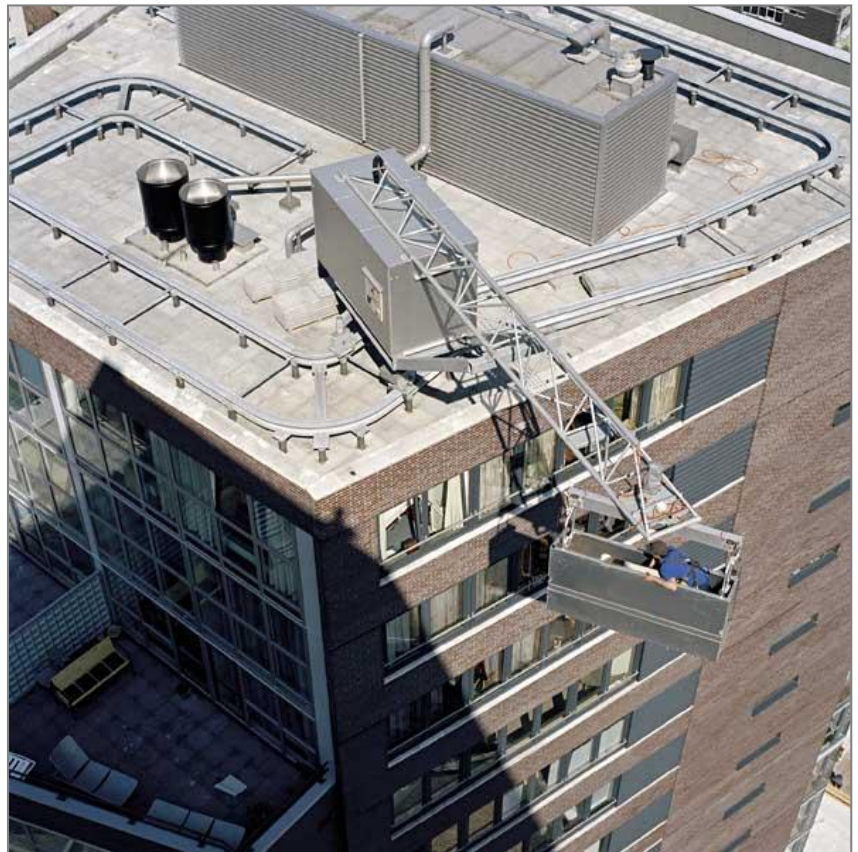
Fig. 1 | Railconstructie op dak
