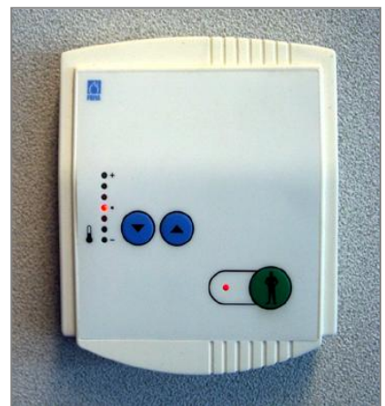
Fig. 2 | Plaats thermostaten in ruimten
