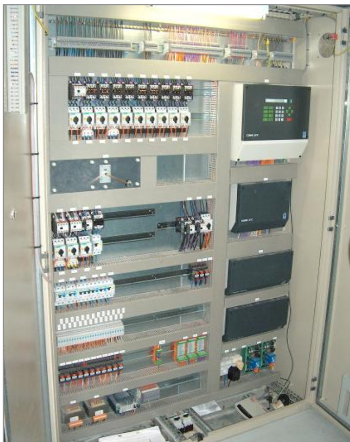
Fig. 1 | Voorbeeld van een regelkast
