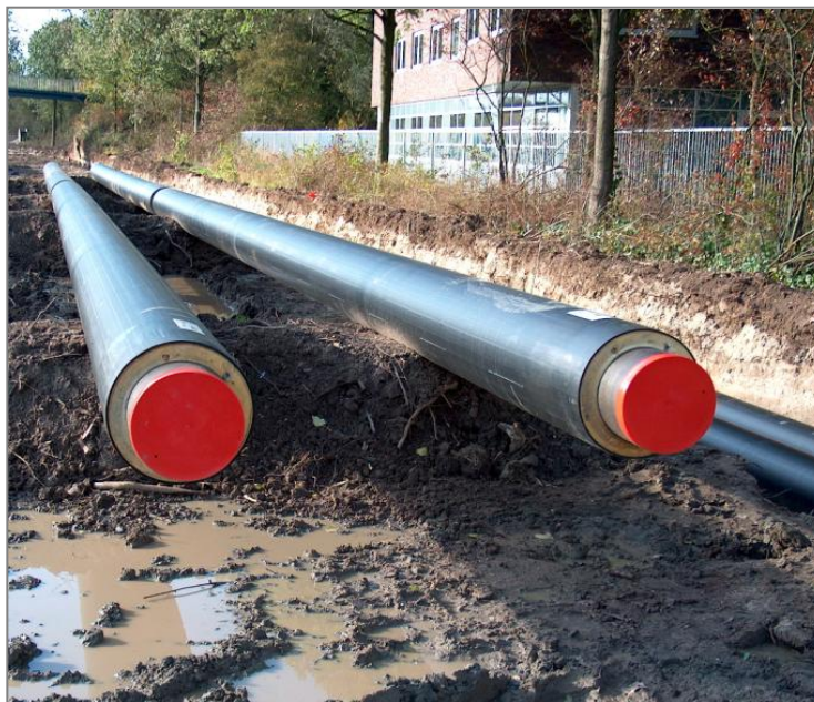
Fig. 1 | Aanleg van stadsverwarming
