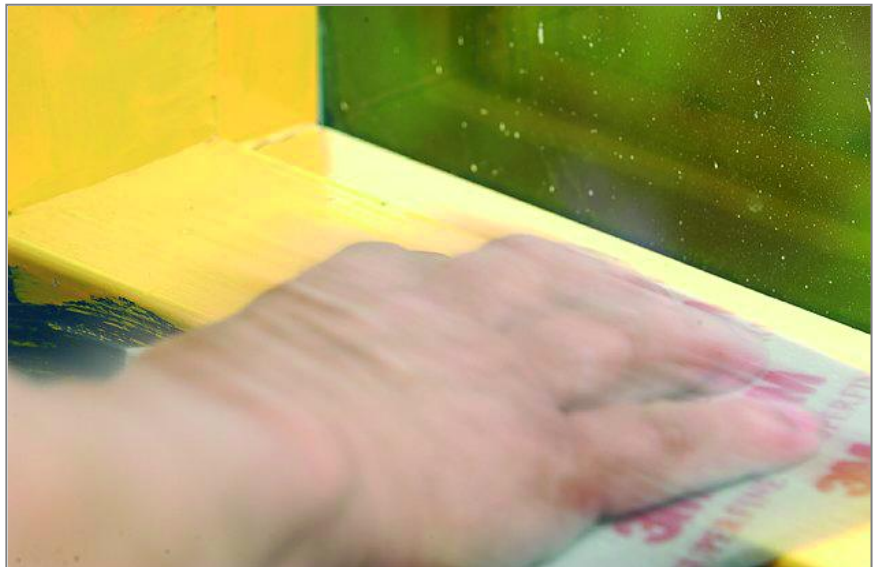
Fig. 2 | Als er sprake is van verwerking moet onder andere het verweerde en verbleekte hout worden verwijderd door middel van schrappen en schuren.
