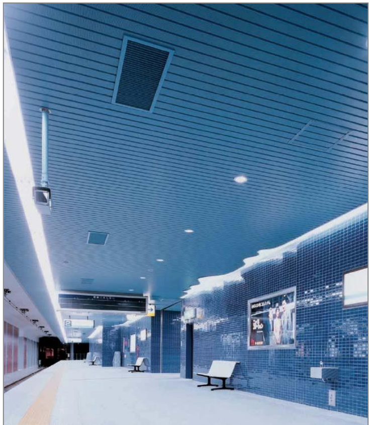
Fig. 1 | Lamellenplafonds als toepassing in een metrostation
