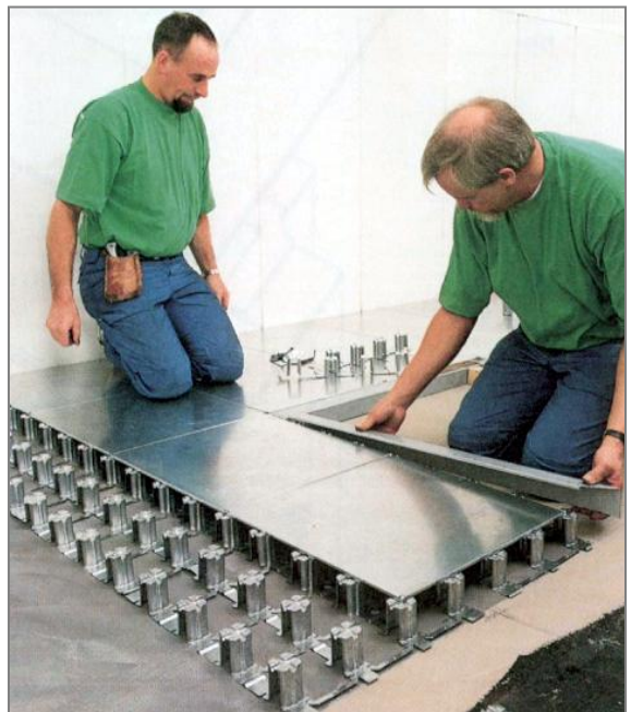
Fig. 2 | Het aanbrengen van randprofielen
