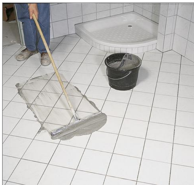
Fig. 1 | Voegen dichtn van de vloertegels
