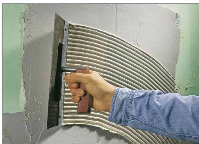
Fig. 2 | Het type ondergrond is altijd maatgevend
