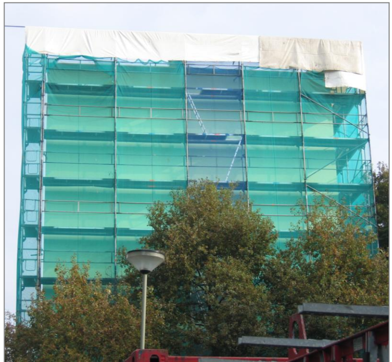
Fig. 1 | Steiger tijdens montage van de gevelisolatie
