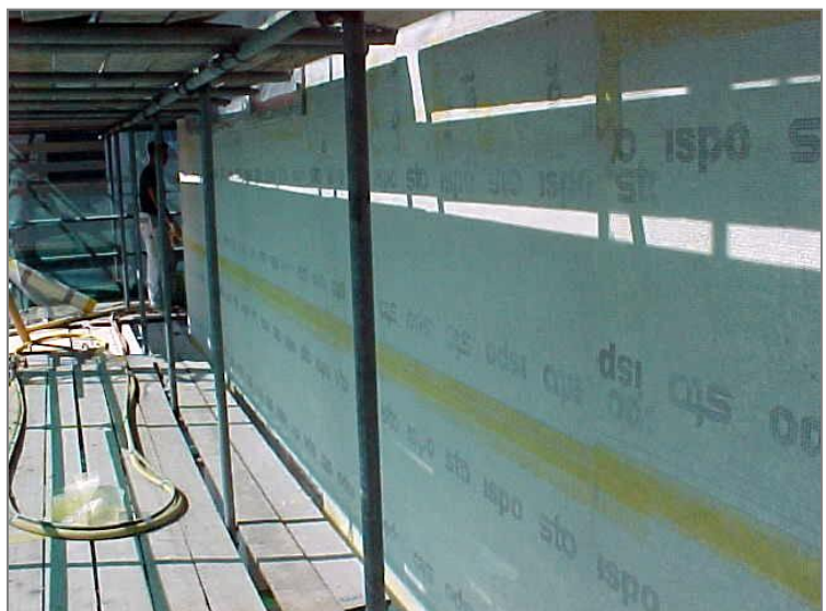
Fig. 2 | Aanbrengen van de isolatieplaten
