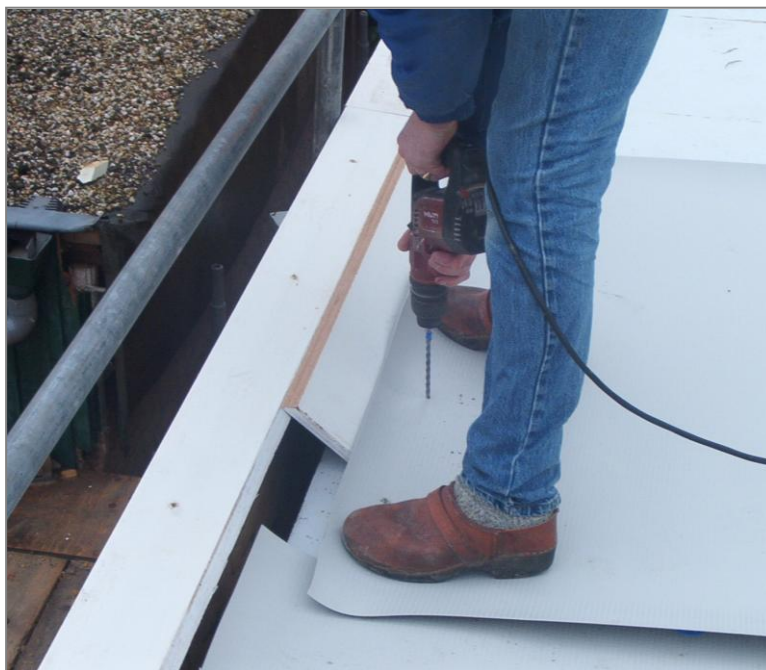
Fig. 1 | Montage van kunststof dakbedekking
