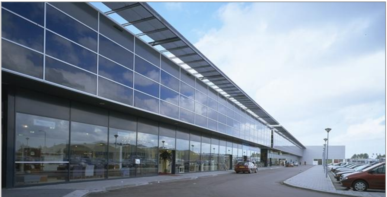
Fig. 2 | De vliesgevel kan worden gebruikt om het gebouw wind- en waterdicht te maken zodat afbouw eerder kan starten
