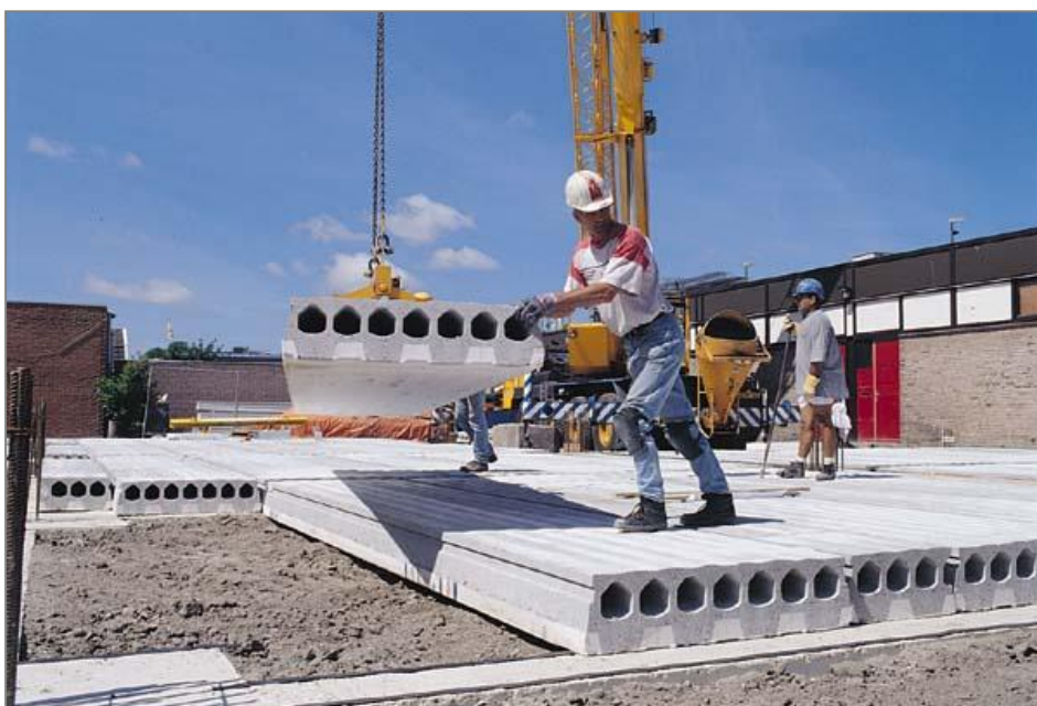
Fig. 2 | Leggen van kanaalplaten
