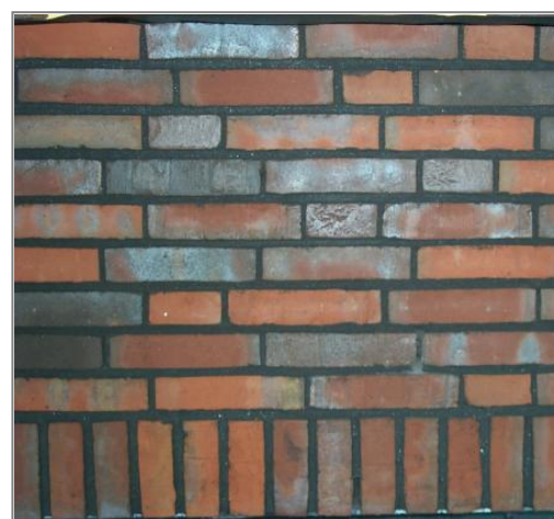
Fig. 1 | Doorgestreekt voegwerk
