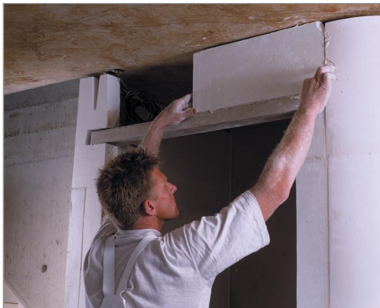
Fig. 2 | Het verwerken van de gipsblokken begint met een zeer zorgvuldige maatvoering
