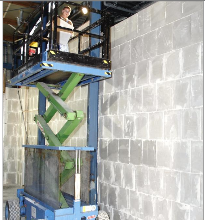
Fig. 1 | Transport van gipsblokken in utiliteitsbouw
