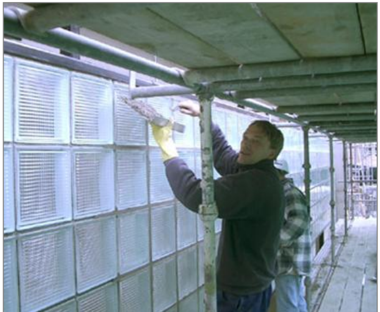
Fig. 2 | Voegwerk van glazen bouwstenen
