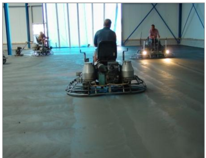
Fig. 1 | In de ontwerpfase moet al rekening gehouden worden met het vlinderen van de vloeren
