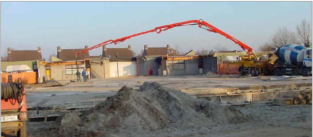
Fig. 2 | Storten van betonvloer met pomp
