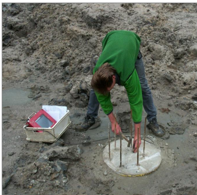
Fig. 1 | Doormeten van de palen voor koppensnellen
