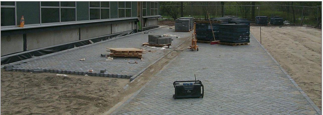
Fig. 2 | Bestrating van de parkeerplaats van het kantoor van het Centraal Bureau Bouwbegeleiding in Arnhem, maart 2002
