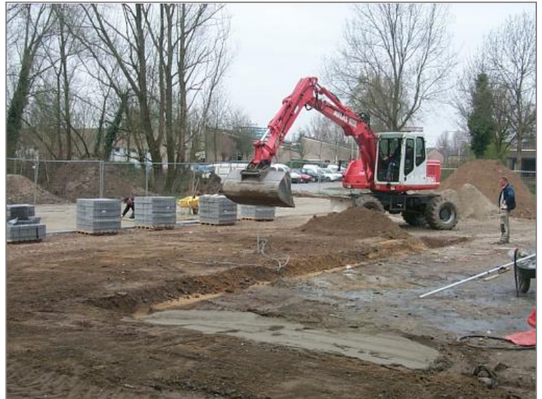
Fig. 1 | Af te voeren grond moet gecontroleerd worden op vervuiling
