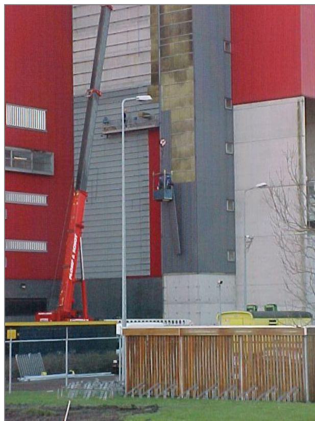
Fig. 1 | Strippen van een gebouw
