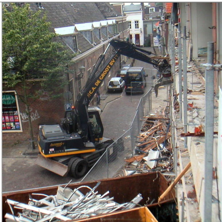
Fig. 1 | Om schadeclaims achteraf te voorkomen, zullen panden van belendende percelen vooraf uitvoerig moeten worden geïnspecteerd
