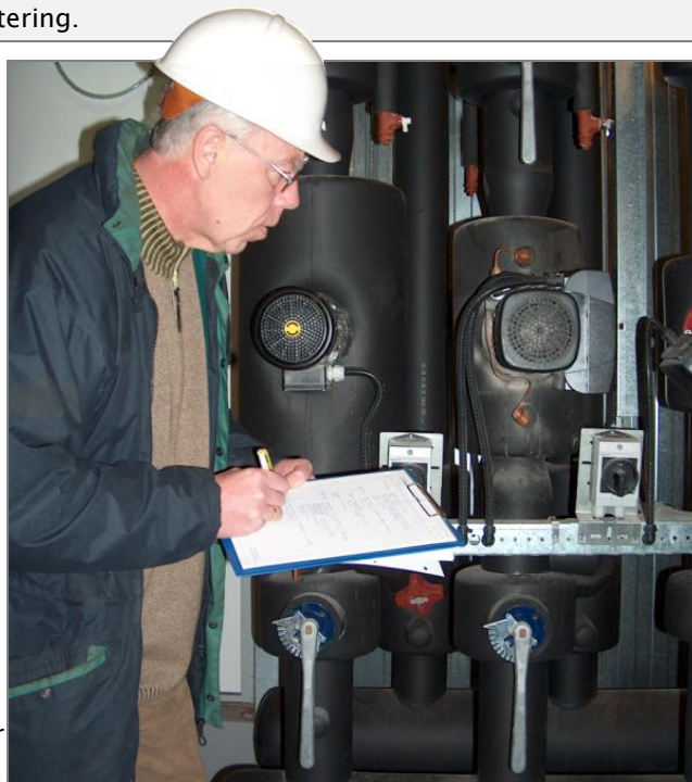
Fig. 2 | Het bouwkundig oog...
